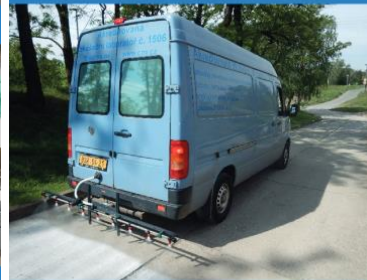
Strojní aplikace FLAX na povrch betonu
