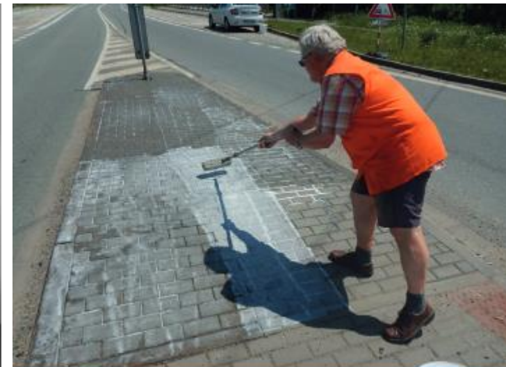
Ruční aplikace FLAX na povrch betonu
